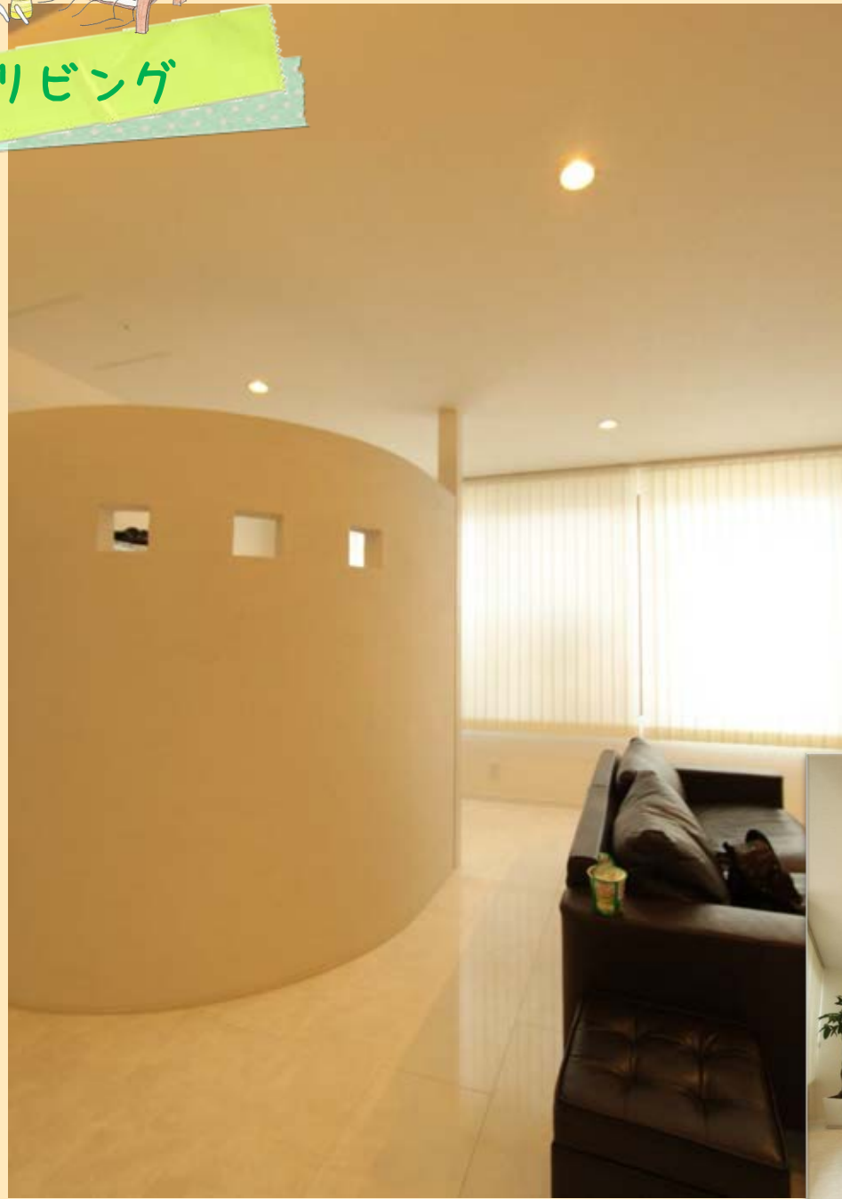
リビングのアクセントになっているアールの壁は珪藻土の塗り壁になっており真っ白な空間のアクセントに。
