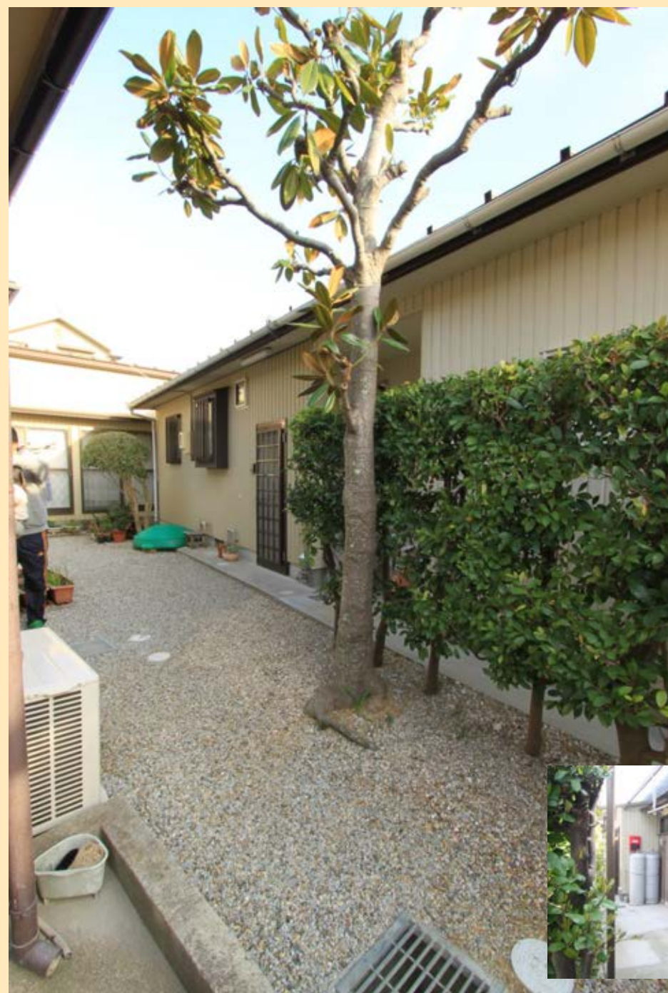
コストを抑え、外観は増築部分だけ貼り替えました。
